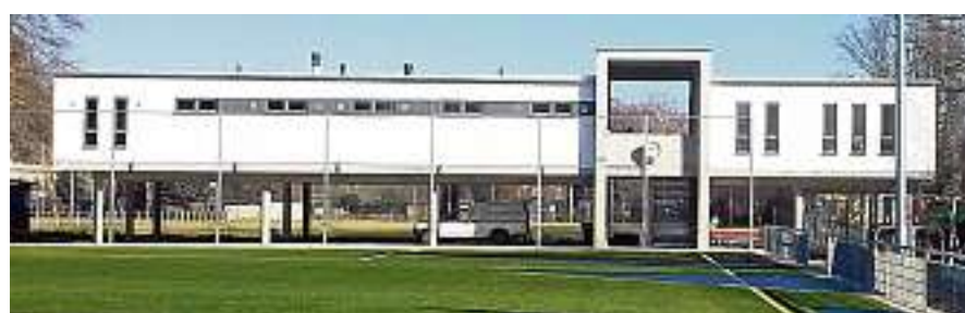
Das neue Sportlerheim ist so gut wie fertig. In der kommenden Woche wird es baurechtlich abgenommen. Offizielle Einweihung wird aber erst am 29. April sein.
