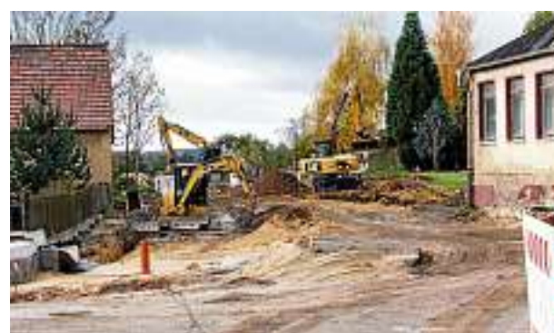
Die Arbeit am nächsten Bauabschnitt läuft – bis der Winter kommt.
