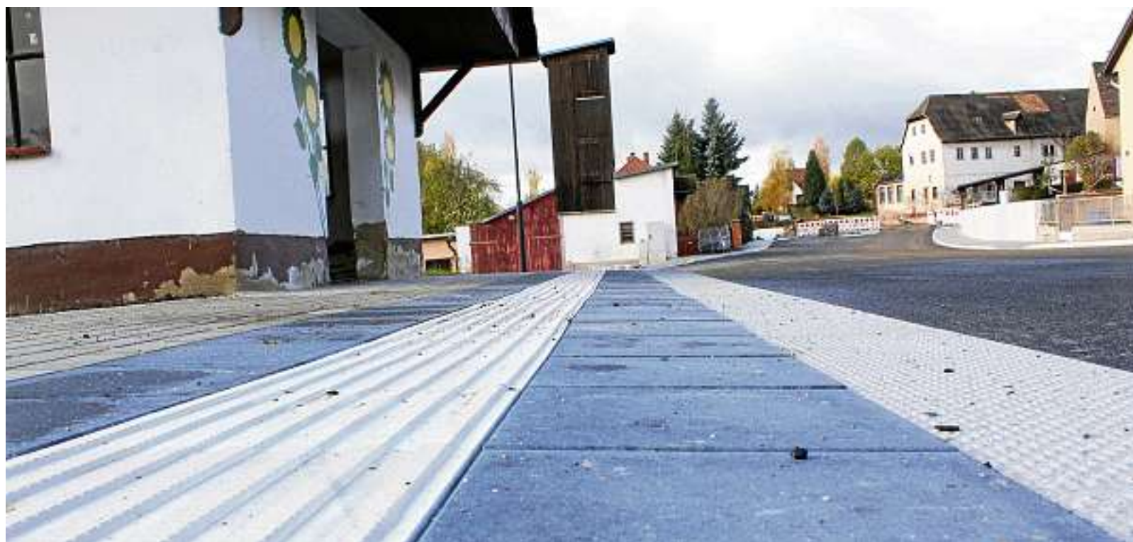
Der Ausbau der B7-Ortsdurchfahrt in Untschen läuft gut. Die Arbeiter sind dem Zeitplan voraus. Mehr Fotos unter www.otz.de Fotos (3): Cordula Fischer
