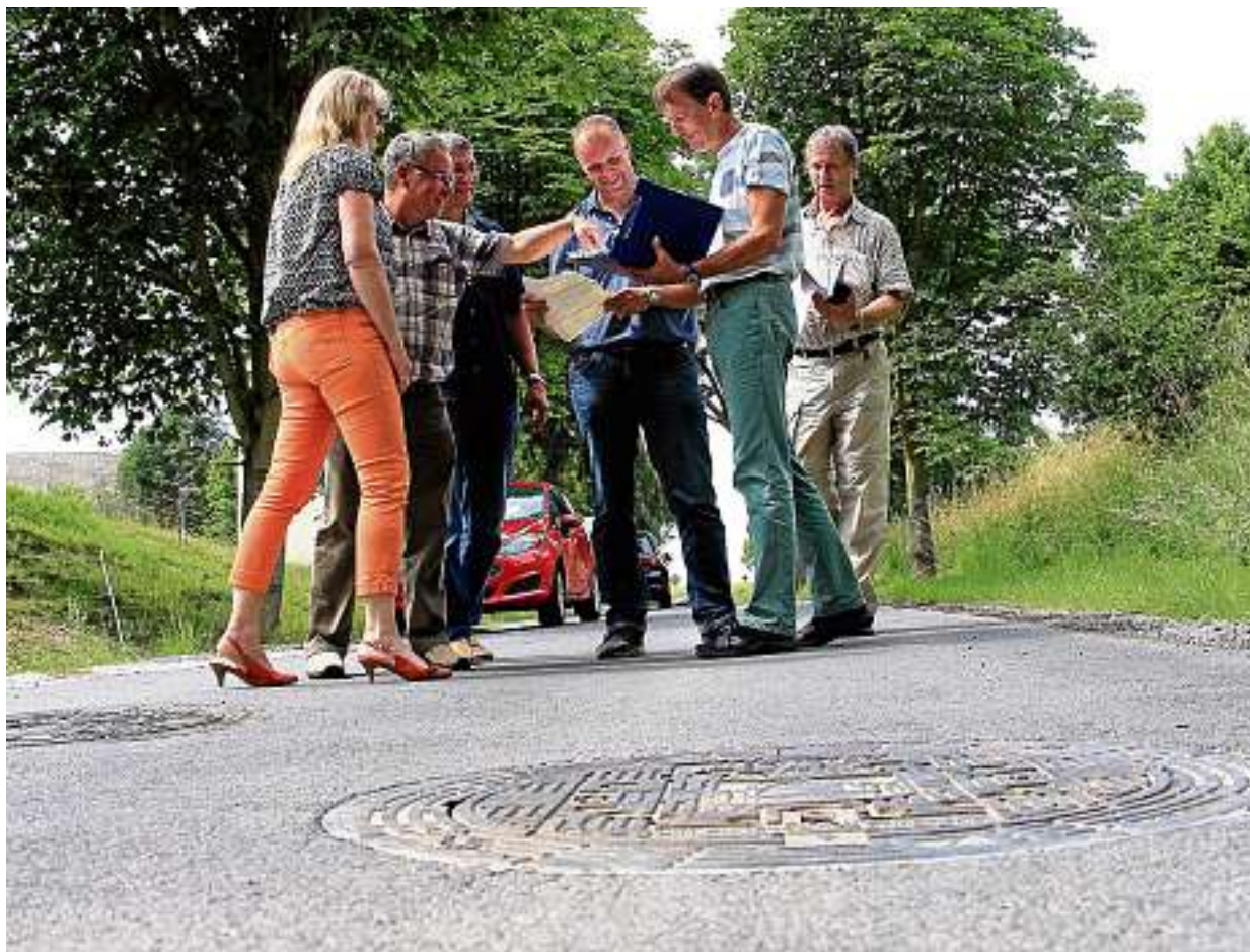
Letzte Überprüfungen auf fertiger Fahrbahn: Planer, Baubetreuer, Vertreter der Baufirma, der Stadtverwaltung und des Amtes für Landentwicklung und Flurneuordnung im Gespräch. Fotos (3): Jana Borath
