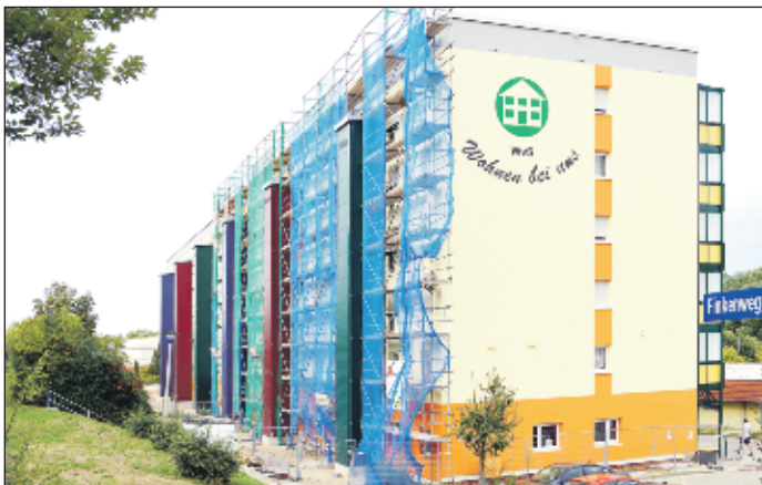
Am Finkenweg 1-6 werden gegenwärtig die Arbeiten für die neuen Aufzüge zum Abschluss gebracht.
